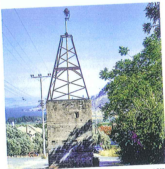
איור 3. הביצרון הצפוני במגדל. מעל הביצרון ניצב מגדל לפרוז'קטור שעדיין ניתן לתפעול
